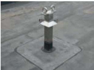
Finir les traversants de toitures avec le Securitan flashing polyback. D'abord vous traitez la surface de travail au Securitan polyback primer. Puis vous finissez le traversant avec du Securitan flashing polyback (arrondir les coins). Prenez soin d'avoir assez de Securitan flashing polyback pour terminer le support en une fois. Ensuite vous appliquez le Securitan flashing polyback le long du support
